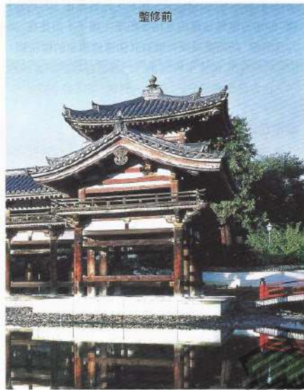
平等院鳳凰堂整修前及整修後
