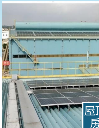
屋頂防墜設施合格照片(設置臨時性護欄)
