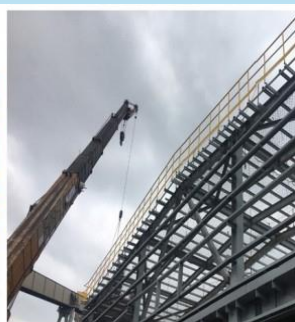
屋頂防墜設施合格照片(廠房屋頂設置永久性欄杆)
