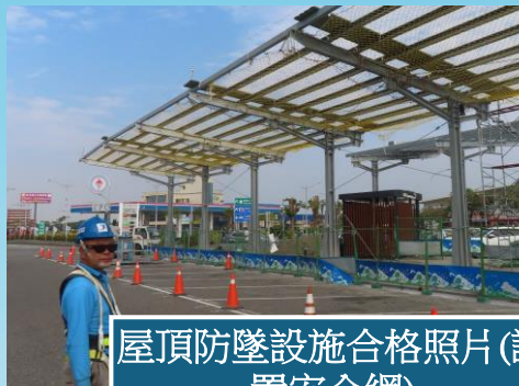
屋頂防墜設施合格照片(設置臨時性護欄)
